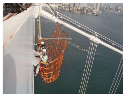
(b) 特殊高所作業者による横梁の塗装補修
