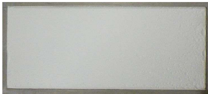
図 6 水性無機塗料の特定の塗料試験片上に発生した微細な膨張
