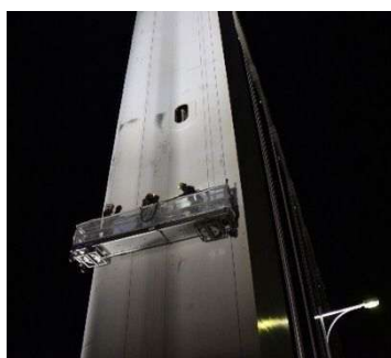
(a) ゴンドラを使った主塔の塗装補修
