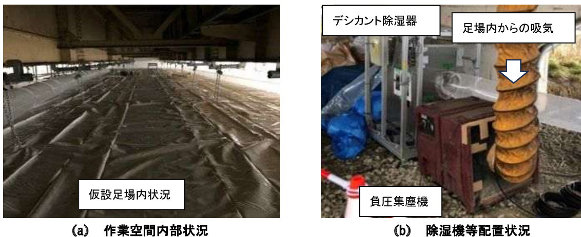
図 1 実証試験状況
