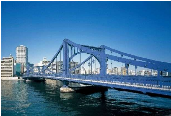
写真 1 約 100 年人々を支えてきた清洲橋
