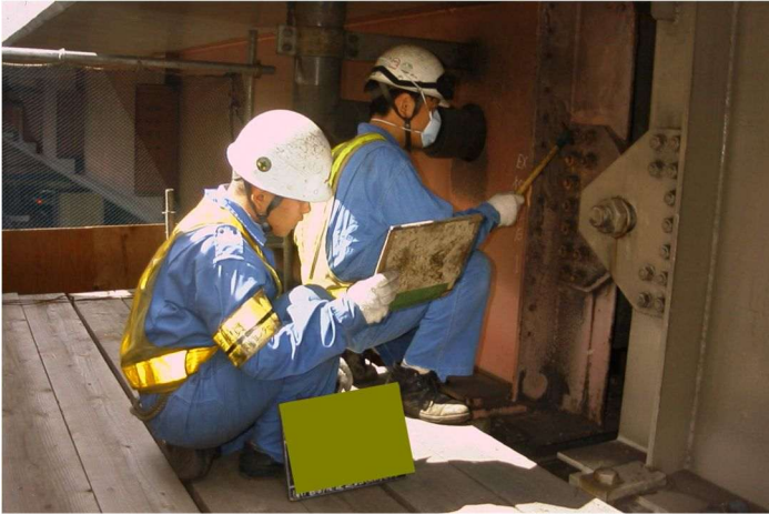
写真3 点検状況：鋼製橋梁外面・連結部
