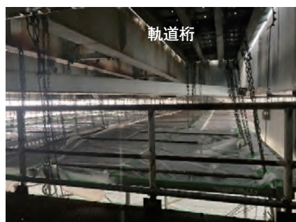
写真-10 上部吊り足場
