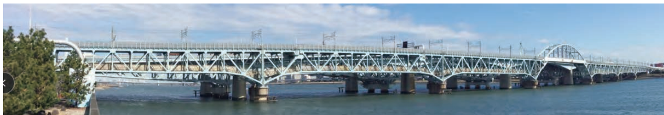
写真-1 荒川放水路橋りょう 全景
