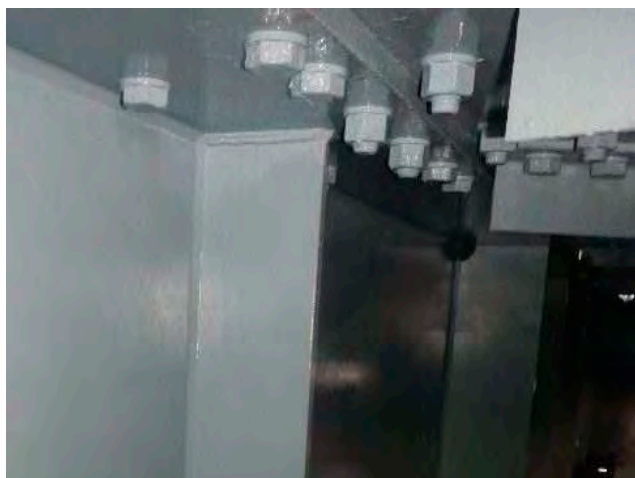
写真-30 疲労き裂に対する当板補強
