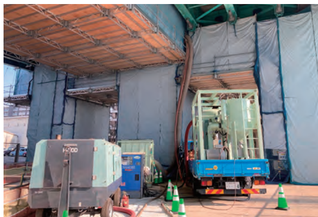
写真-9 ブラスト資機材配置状況
