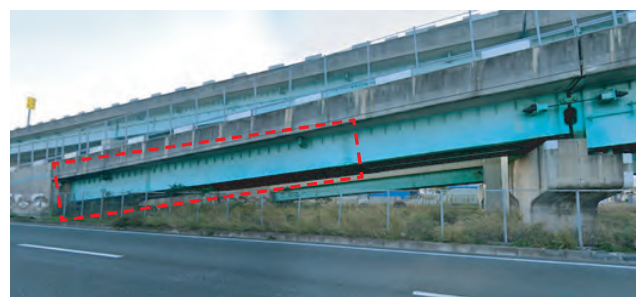
写真-2 試験施工箇所外観
