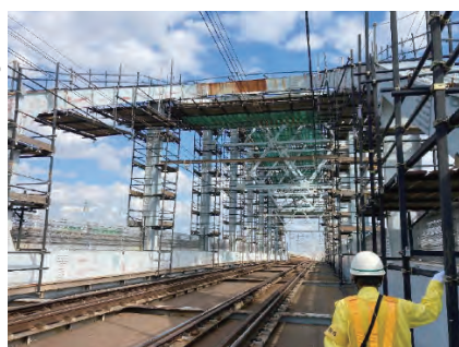
写真-12 抱込み足場
