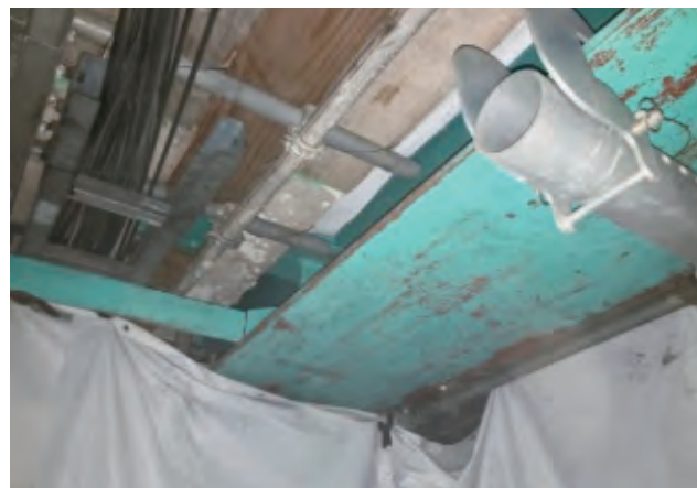
写真-14 ブラスト施工後の状況
