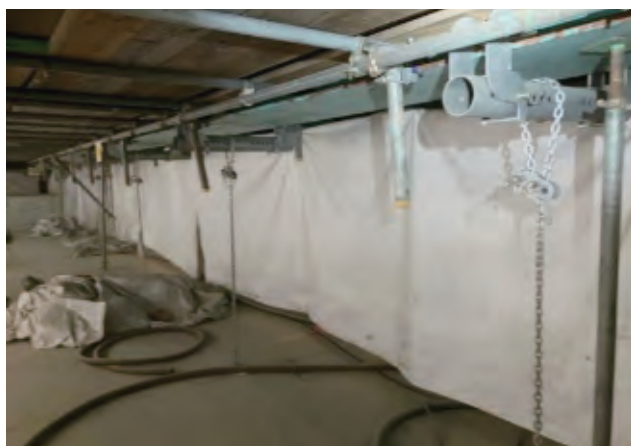
写真-11 養生シートによる施工範囲の区画状況
