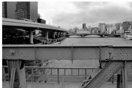
写真-8 車窓から見た隅田川（下流側）
