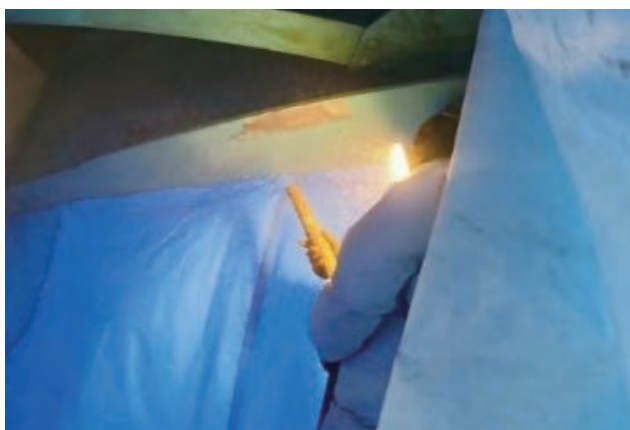
写真-4 コーンによるブラスト状況
