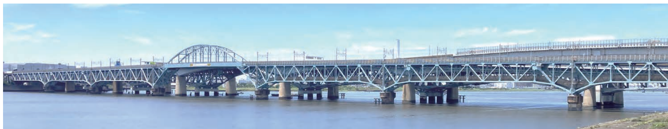
写真-32 工事完了後の荒川放水路橋りょう
