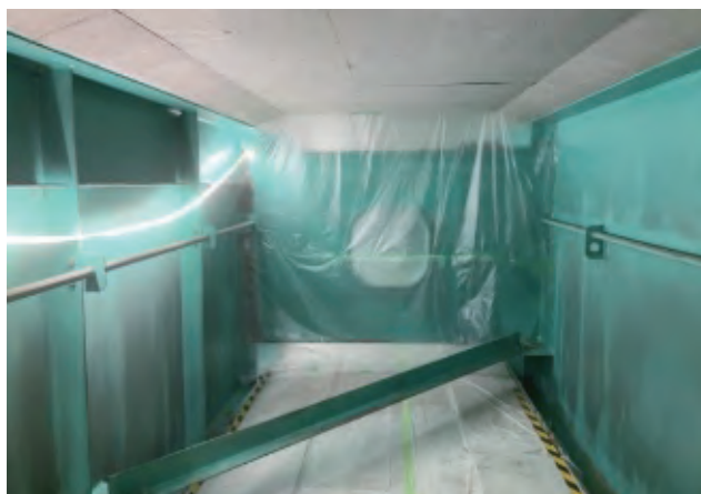
写真-12 マスカー等での施工範囲外の保護状況
