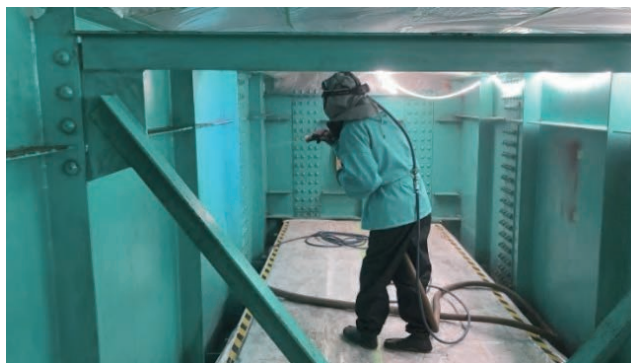
写真-10 素地調整状況
