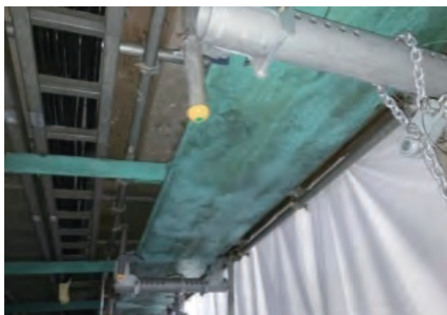
写真-13 ブラスト施工前の状況
