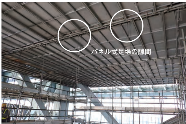
写真-19 ワイヤー吊り足場①
