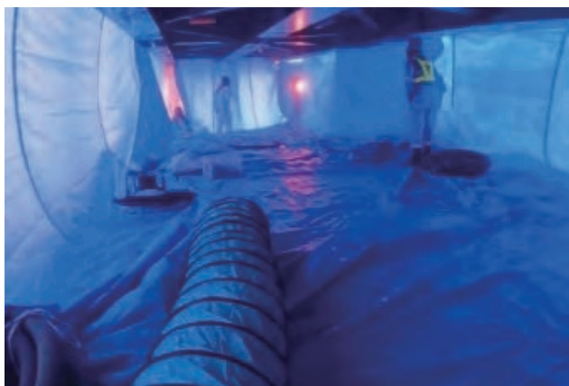
写真-5 養生内の視界状況
