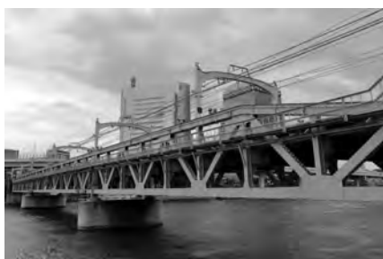
写真-1 隅田川橋梁（近景）
