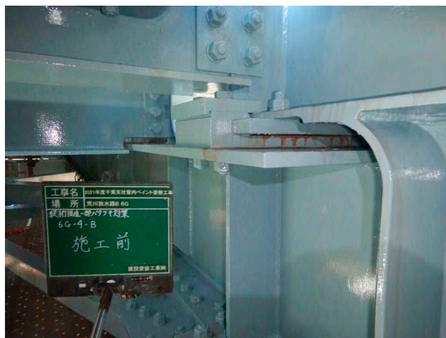
写真-31 支承ライナープレート挿入
