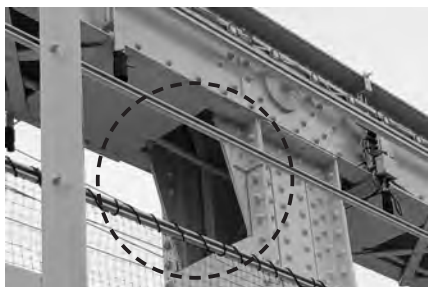
写真-6 垂直材の上部（ピンA部）
