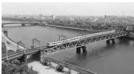
写真-2 隅田川橋梁（遠景）
