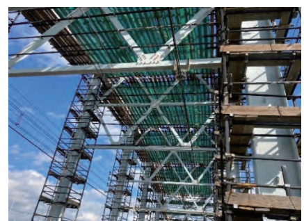
写真-13 アーチ上部吊り足場
