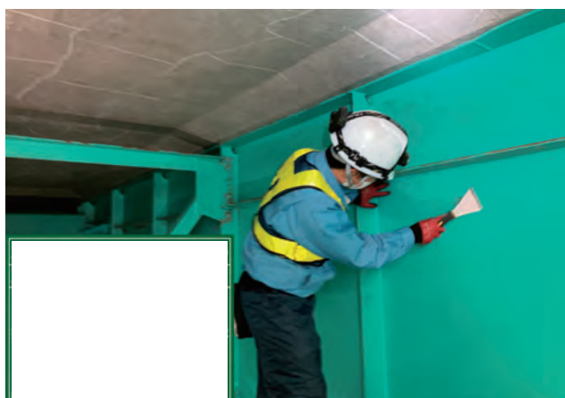
写真-17 スクレーパーによる確認状況
