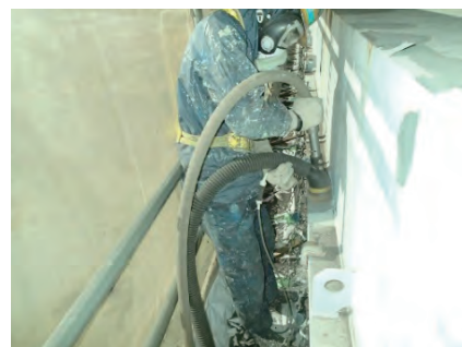
写真-24 小型バキュームブラスト(作業中)
