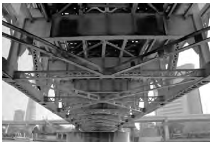
写真-7 本橋下面部の構造
