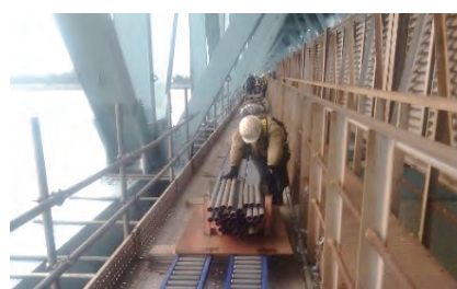
写真-17 資材搬入 (下段通路)
