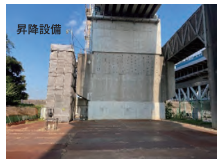
写真-14 昇降設備 (枠組み足場)
